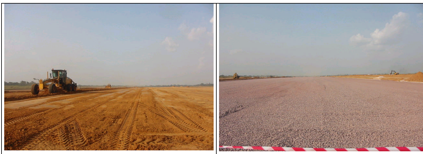
Photos 06: Ollombo: terrassement et 1 o couche de la future piste
